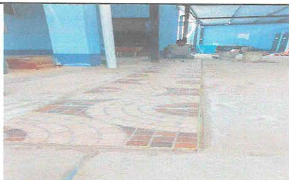
Foto 3. Colocando Piso antideslizante en Patio
