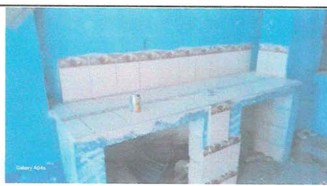
Foto 4. Colocando Ceramico en area donde cocinan la alimentacion Escolar
