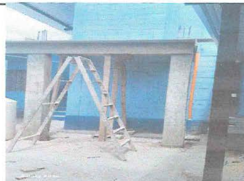
foto 10. Construccion de base para instalacion de tinacos
