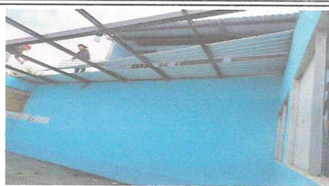
Foto 2. Colocando Lamina Troquelada en aulas
