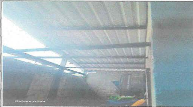
Foto 7. lamina en bodega
