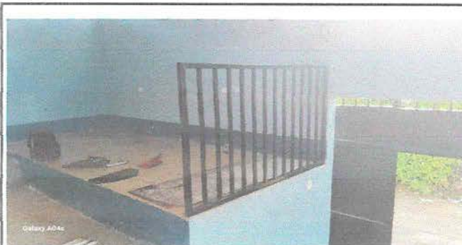
Foto 11 Instalacion de Baranda de seguridad
